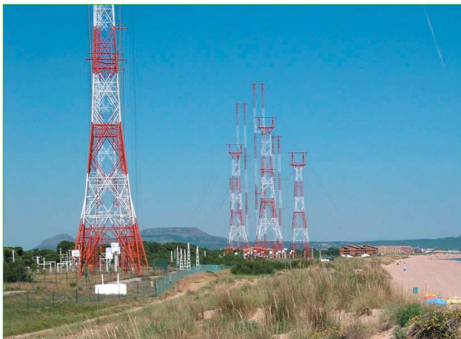
Les antenes de Pals abans de la seva demolició
